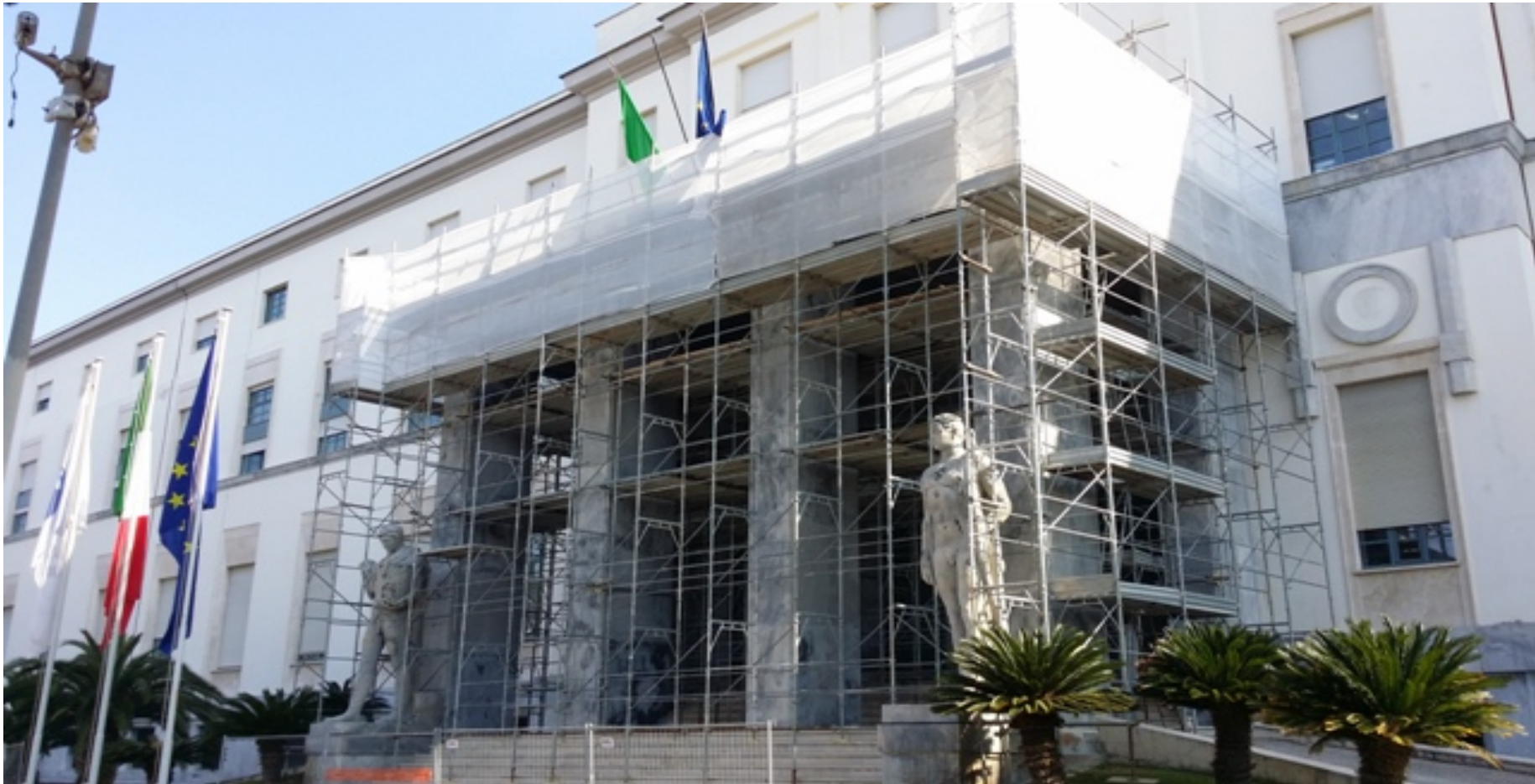
CASERMA "IV NOVEMBRE" Ostia – Roma Lavori di restauro, risanamento conservativo dell'ingresso Monumentale e del lastrico solare Edificio sottoposto a tutela.
