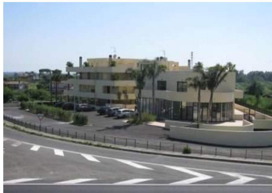
Torrimpietra- Costruzione di edifici residenziali e commerciali
