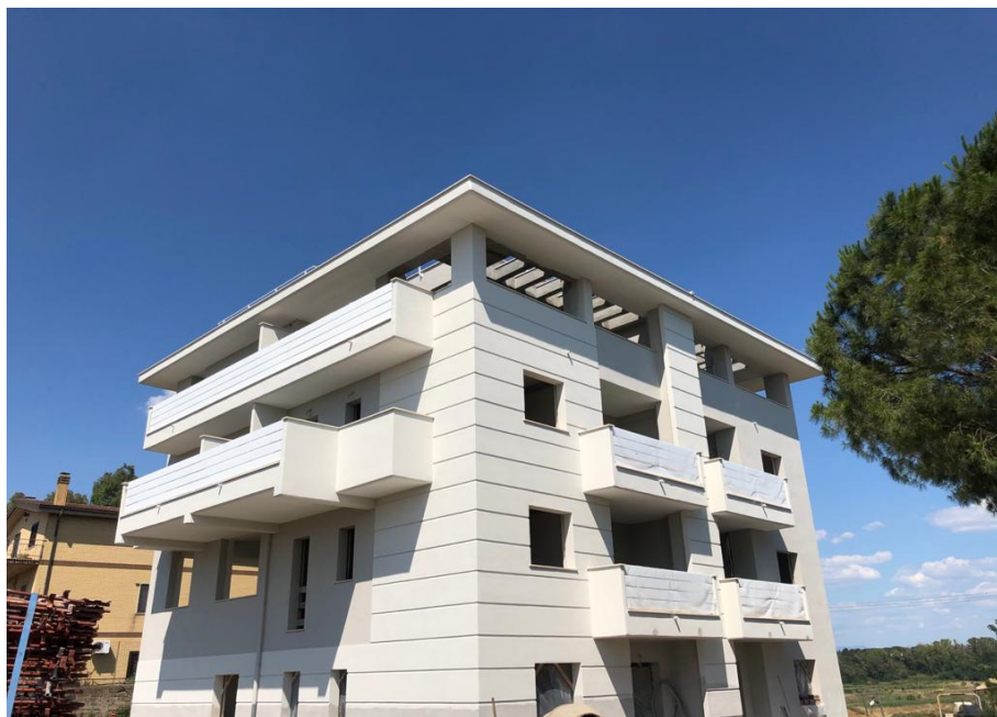
Roma Via Arzana – Costruzione di Palazzina classe energetica A++++
