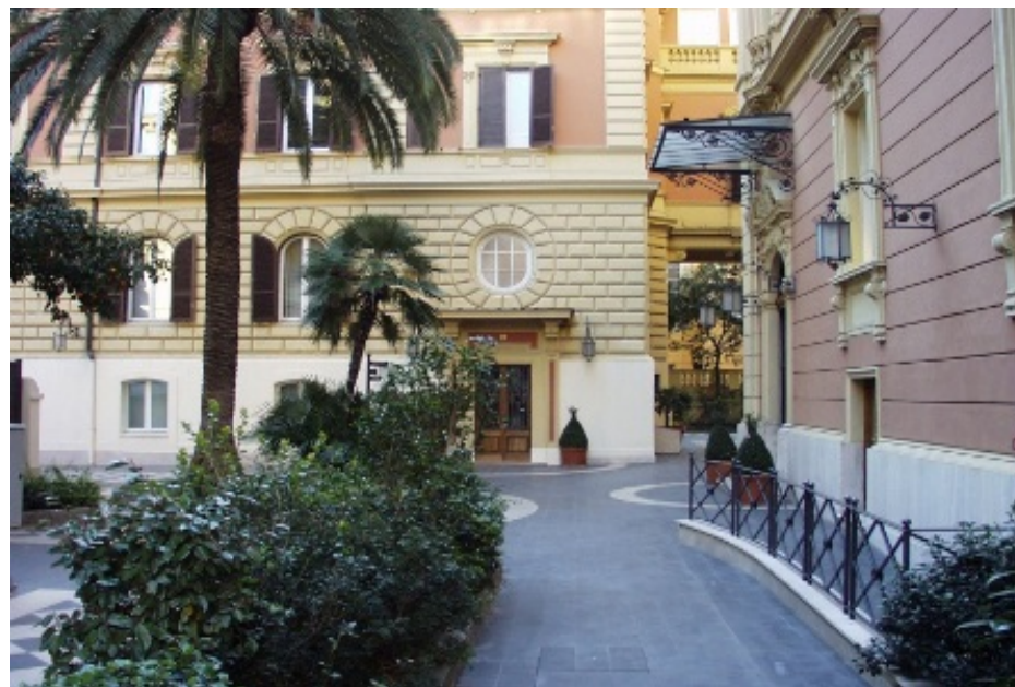
Medio Credito Centrale S.p.a. - Ristrutturazione completa di due palazzine in Via Piemonte, Roma
