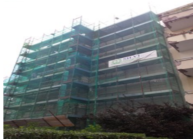
Immobile in Roma - P.zza Jacini Risanamento facciate e coperture
